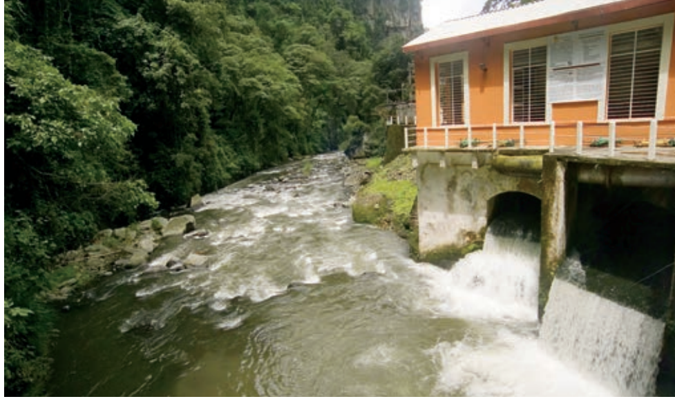
Presa hidroeléctrica, Texolo, Xico, Veracruz.
